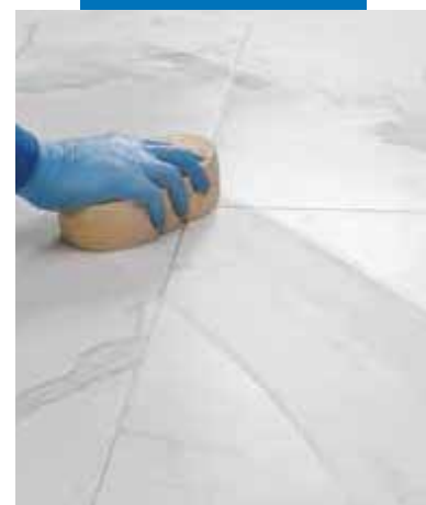
Почистване и финалиране на фугите с твърда целулозна гъба
