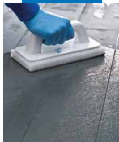
Почистване на фугите с гладилка със Scotch Brite® подложка, след като продуктът е полутвърден
