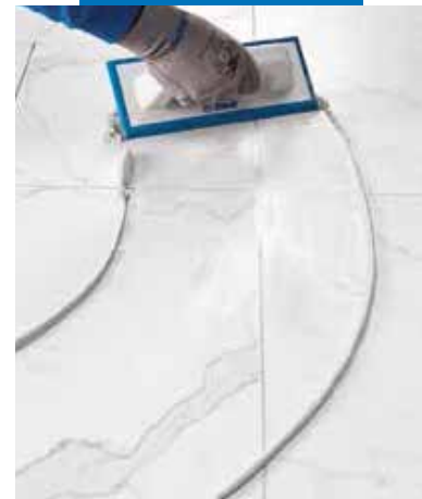
Разстилане на Ultracolor Plus върху подови гранитогресни плочки с мраморен ефект с помощта на гумена маламашка
