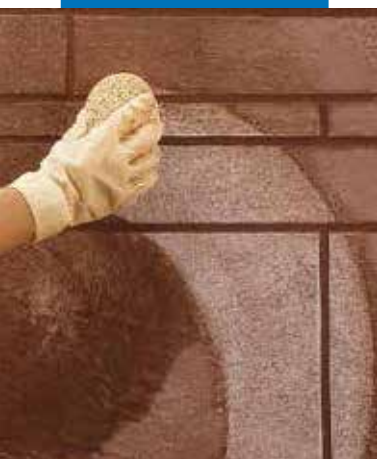
Почистване и финализиране на фугите между плочки с помощта на гъба
