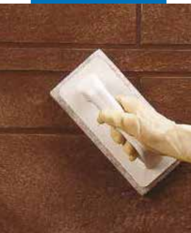
Почистване на фугите със Scotch Brite® след като продуктът е стегнал частично
