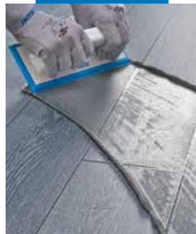
Разстилане на Ultracolor Plus върху подови гранитогресни плочки с ефект а дърво с гумена маламашка
