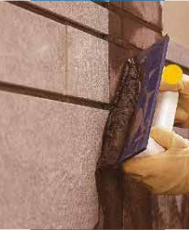
Разстилане на Ultracolor Plus по стена с гумена маламашка
